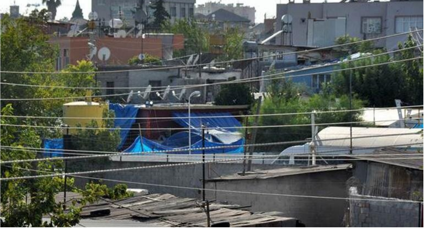
Tarsus 82 Evler Mahallesi'nde kazı yapılan alan.
